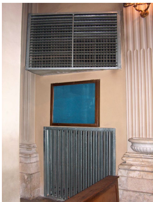
Figura 8: La cappella tamponata prima del ripristino
