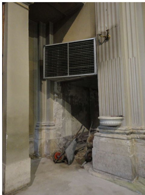
Figura 9: Eliminazione della tamponatura nel 2011
